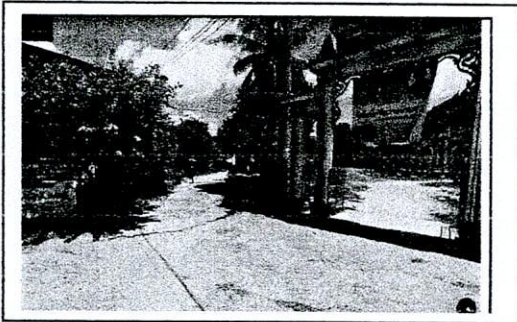
กม. ๐+๐๐๐ จุดเริ่มต้นโครงการ คสล.กว้าง ๔ ม. ไหล่ทาง ๐.๒๐
