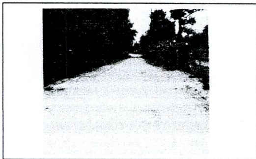
กม. ๐+๖๐๐ คสล กว้าง ๔ ม. ไหล่ทางข้างละ ๐.๕๐ ม.
