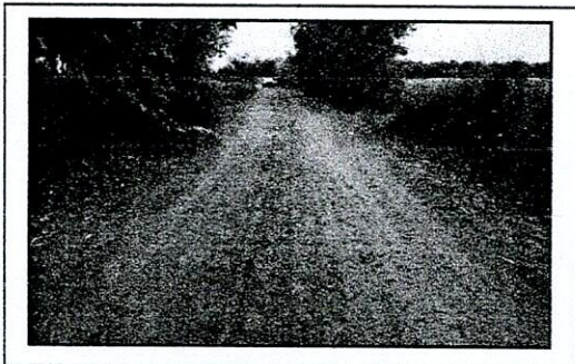
กม. ๑+๐๐๐ หินคลุก กว้าง ๔ ม. ไหล่ทางข้างละ ๐.๕๐
