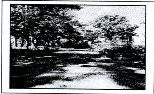
กม. ๑+๕๖๐ จุดสิ้นสุดโครงการ(หินคลุก กว้าง ๔ ม. ไหล่ทางลูกรังกว้างข้างละ ๐.๕๐ ม.
