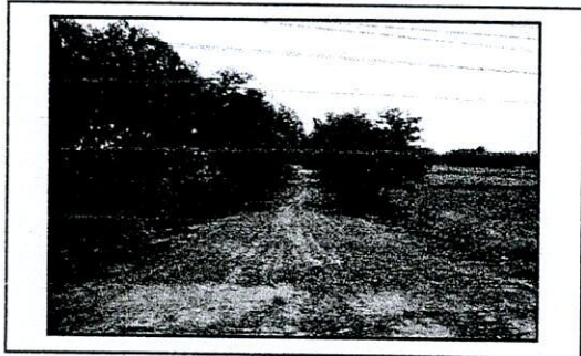
กม. ๑+๕๐๐ จุดสิ้นสุดโครงการ(หินคลุก กว้าง ๔ ม. ไหล่ทางลูกรังกว้างข้างละ ๐.๕๐ ม.
