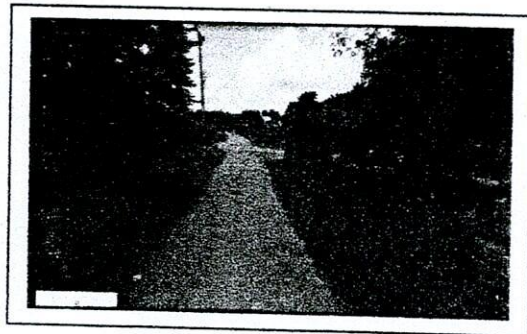
กม. ๐+๙๕๕ จุดสิ้นสุดโครงการ หินคลุก กว้าง ๕ ม. ไหล่ทางลูกรังกว้างข้างละ ๐.๕๐ ม.
