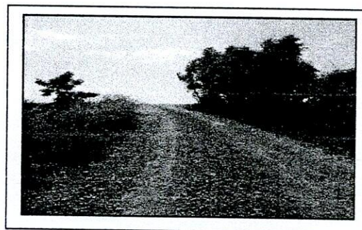
กม. ๑+๖๗๐ จุดสิ้นสุดโครงการ หินคลุก กว้าง ๔ ม. ไหล่ทางลูกรังกว้างข้างละ ๐.๕๐ ม.
