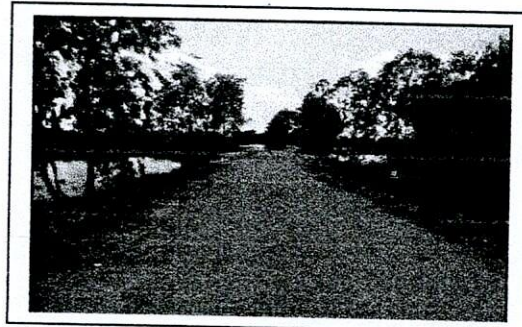
กม. ๓+๐๐๐ จุดสิ้นสุดโครงการ(หินคลุก กว้าง ๔ ม. ไหล่ทางลูกรังกว้างข้างละ ๐.๕๐ ม.
