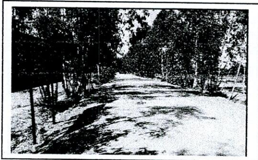
กม. ๑+๕๐๐ หินคลุก กว้าง ๔ ม. ไหล่ทางข้างละ ๐.๕๐
