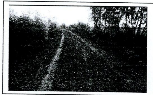
กม. ๑+๐๐๐ คสล. กว้าง ๔ ม. ไหล่ทางข้างละ ๐.๒๐ ม.
