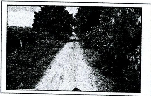
กม. ๐+๘๐๐ หินคลุก กว้าง ๕ ม. ไหล่ทางข้างละ ๐.๕๐
